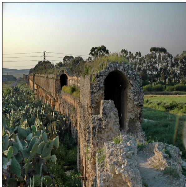
On n'est pas encore très haut, 3 mètres environ ; si vous pensez tomber, choisissez plutôt le côté droit de l'ouvrage !
