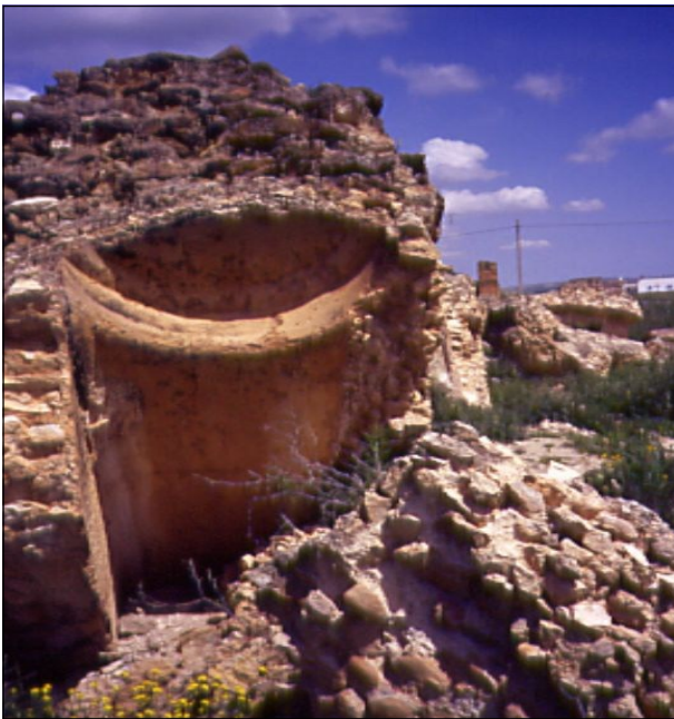
Reste d'un regard de visite sur arches ; sauf exception, comme ceux disposés au sol, ils font tous un pied de profondeur.
