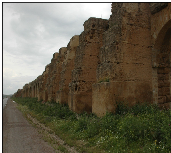
Des contreforts ont été disposés par endroits pour soutenir les arches les plus hautes.
