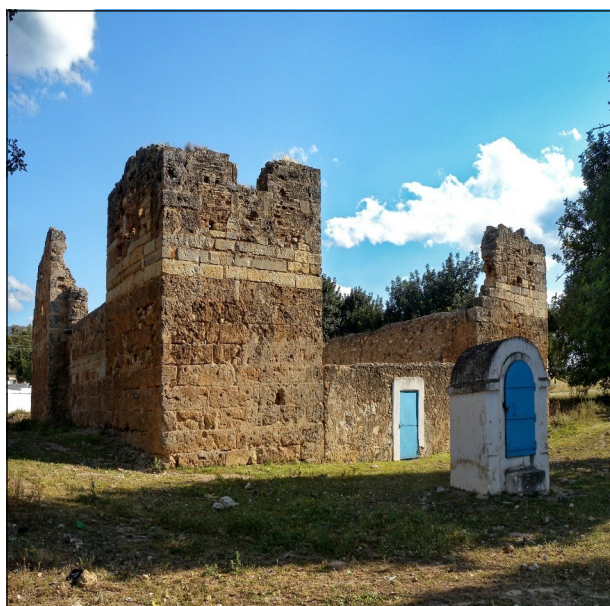
Le fortin renferme les deux sources principales situées le plus en amont de l'aqueduc de Carthage.
