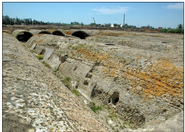
Les petits réservoirs installés entre les citernes et les orifices par lesquels l'eau pouvait se déverser à l'intérieur de celles-ci..
