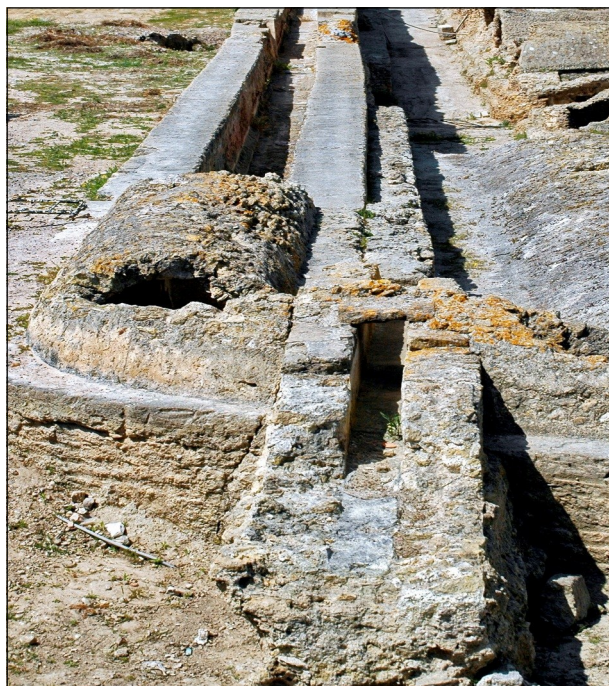
A gauche l'aqueduc qui après un virage, passe sous un autre petit conduit cité dans le texte
