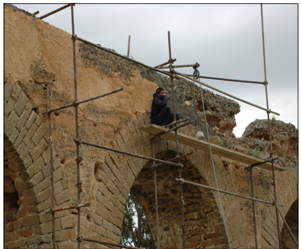
Des travaux de restauration sont en cours
