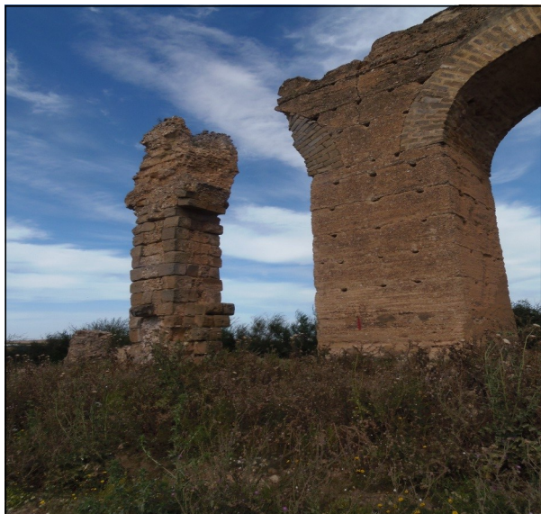
« Habillage » de certaines arches en pisé recouvrant les pierres de la construction antique.
