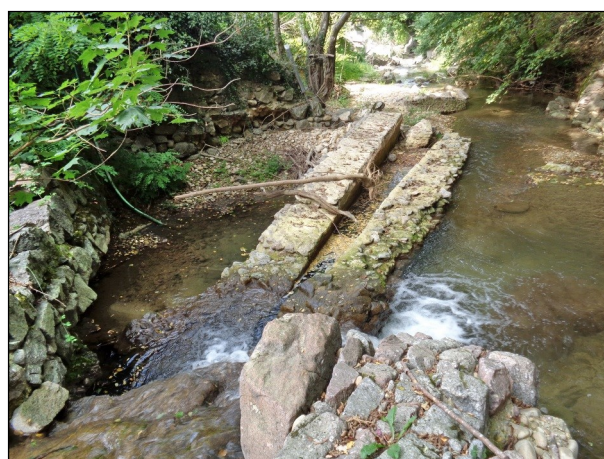
13 - Barrage-aqueduc de la Suze – HS
