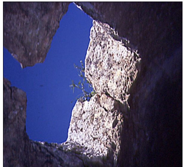
Un des « événements » dans la voûte pour aérer le canal.
